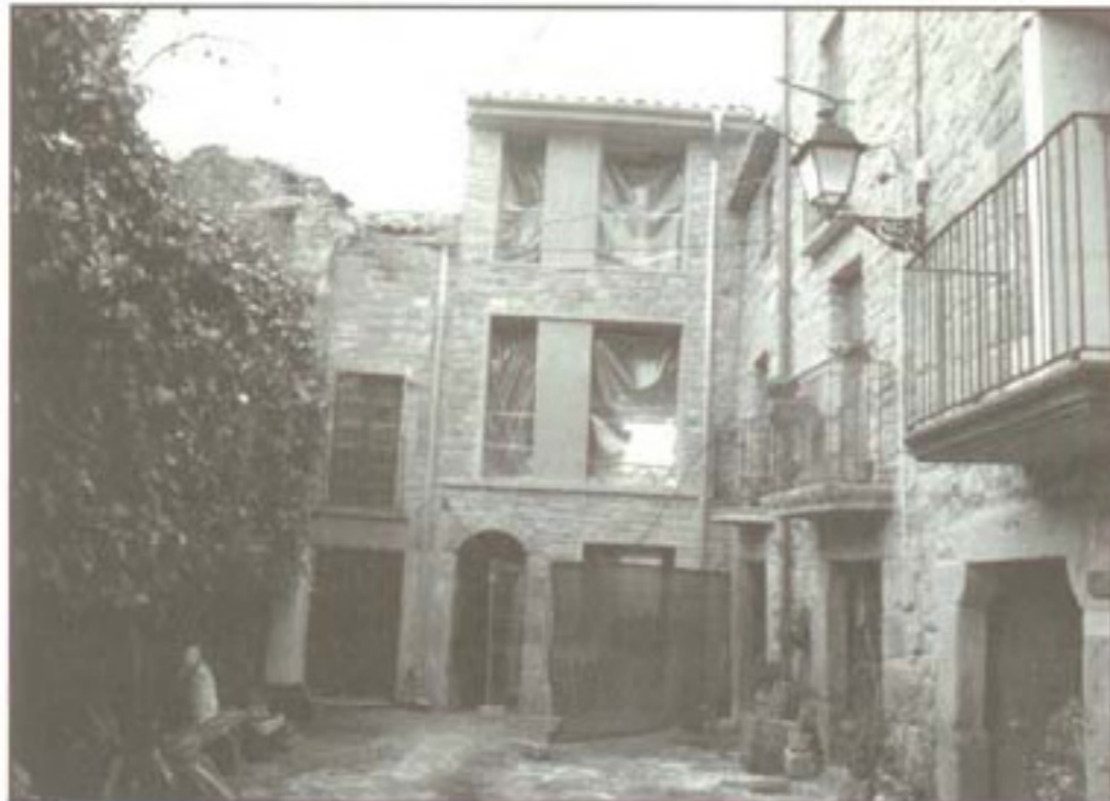
Aspecte actual de l'estat del renovat edifici de les antigues escoles
